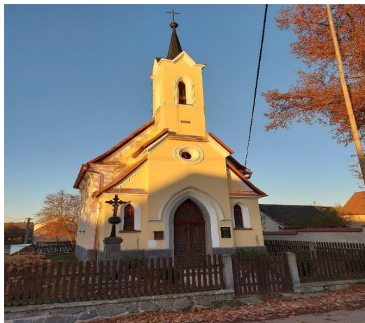
Kaplička v Pechově Lhotě na návsi se teď pyšní novou střechou
